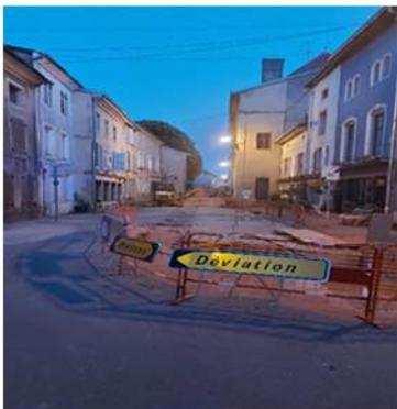
**2020 :** D'importants travaux de remplacement d'une partie du réseau potable de la Cité ont été réalisés par le Syndicat des Eaux de Bénamont depuis 2020. Ces travaux ont débuté rue Meynier, avec le remplacement de la conduite principale depuis l'intersection rue Soeur Catherine jusqu'à l'intersection rue de la Gare,
